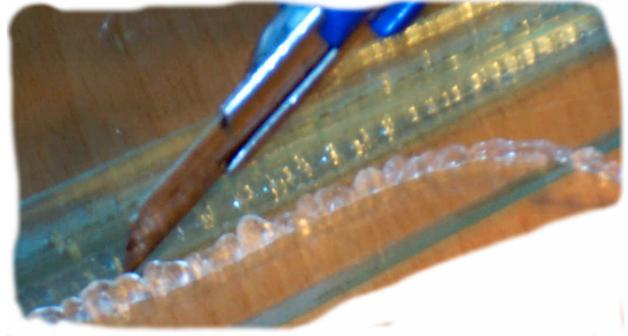
**Achtung:** nicht in die Fuge hineinschneiden sondern nur das überstehende Material entfernen.
